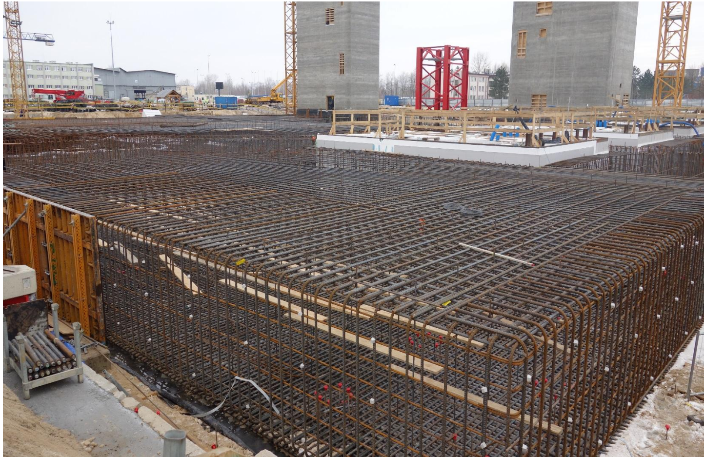
zbrojenie fundamentu budynku kotłowni
