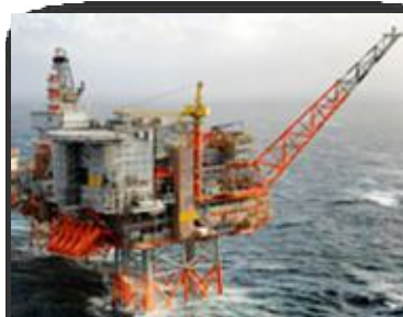
Valhall 80 MW HVDC Zasilanie z brzegu
