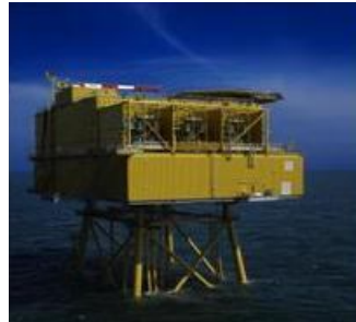
Borwin 1 400 MW przyłącze HVDC
